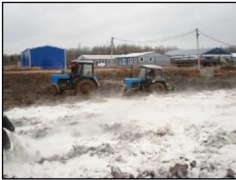
Resim 3: Basit Tarım Aletleri ile Karıştırma İşlemi
