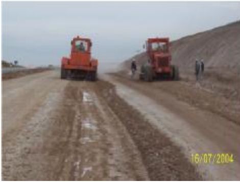
Resim 7: Greyder ile Karıştırma
