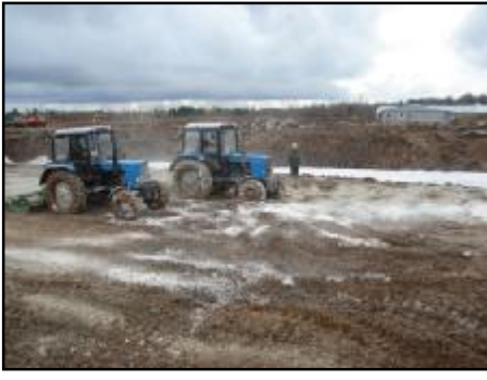
Resim 5: B Bölgesi Kireç ve Çamurun Karıştırılması
