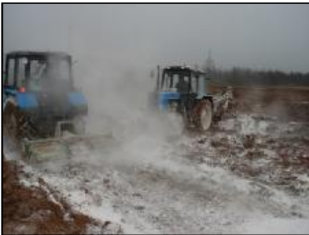
Resim 11: C Bölgesi Çamur ve Kirecin Karıştırılması
